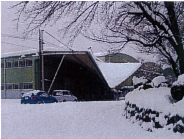
製品出荷場の底部分の崩落
